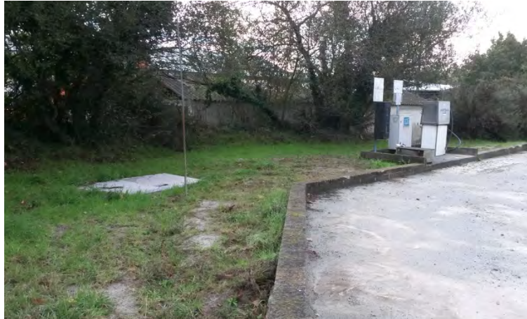
Figure 3 : Poste de distribution et cuve enterrée de GNR
